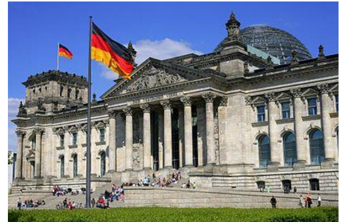
Le Reichstag à Berlin est chauffé et refroidi par deux aquifères, c'est-à-dire deux ATES
