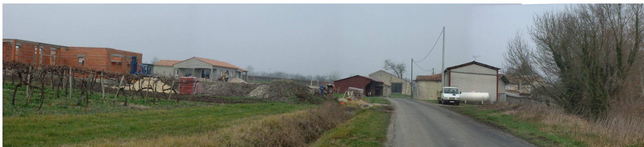
Constructions neuves à la sortie du hameau Bergeon
