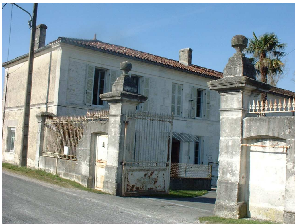
Habitation en moellon Chez Chéraud. Les chaînages d'angle, les encadrements d'ouvertures, bandeaux et corniches sont cependant en pierres de taille. Deux piliers ornés encadrent l'entrée
