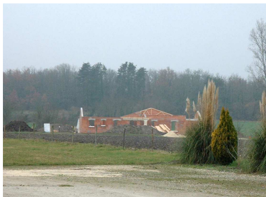
Construction en cours derrière la place communale
