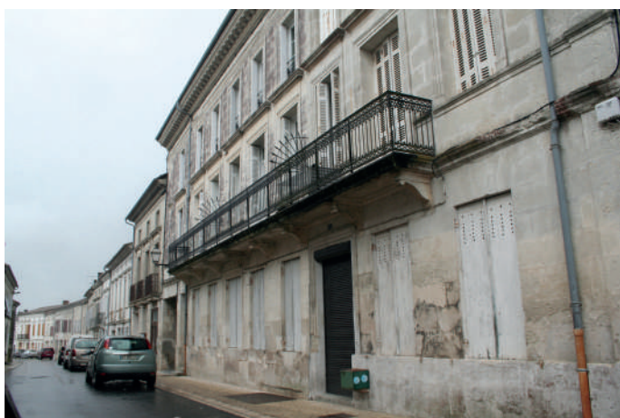
▲ Logements inhabités à Montlieu-la-Garde – Cittanova –
