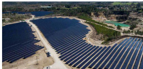
Centrale photovoltaïque au sol sur la commune Le Fouilloux (EDF Renouvelables)
