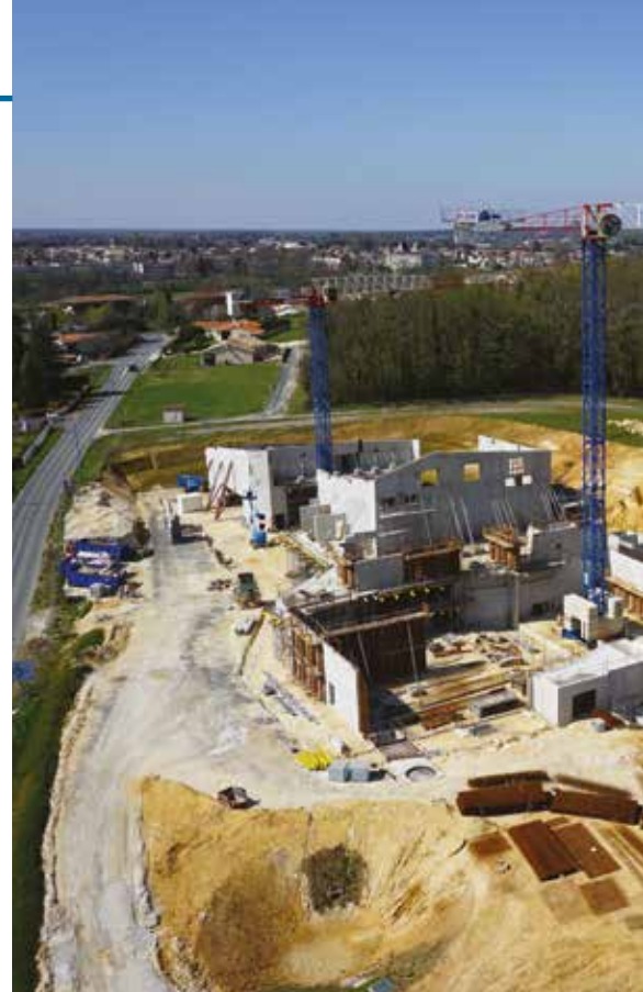
Travaux de construction du Centre des Congrès à Jonzac
