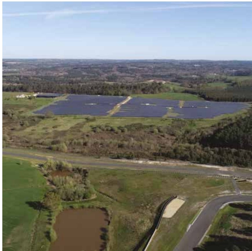
Parc photovoltaïque de La Genêtouze
