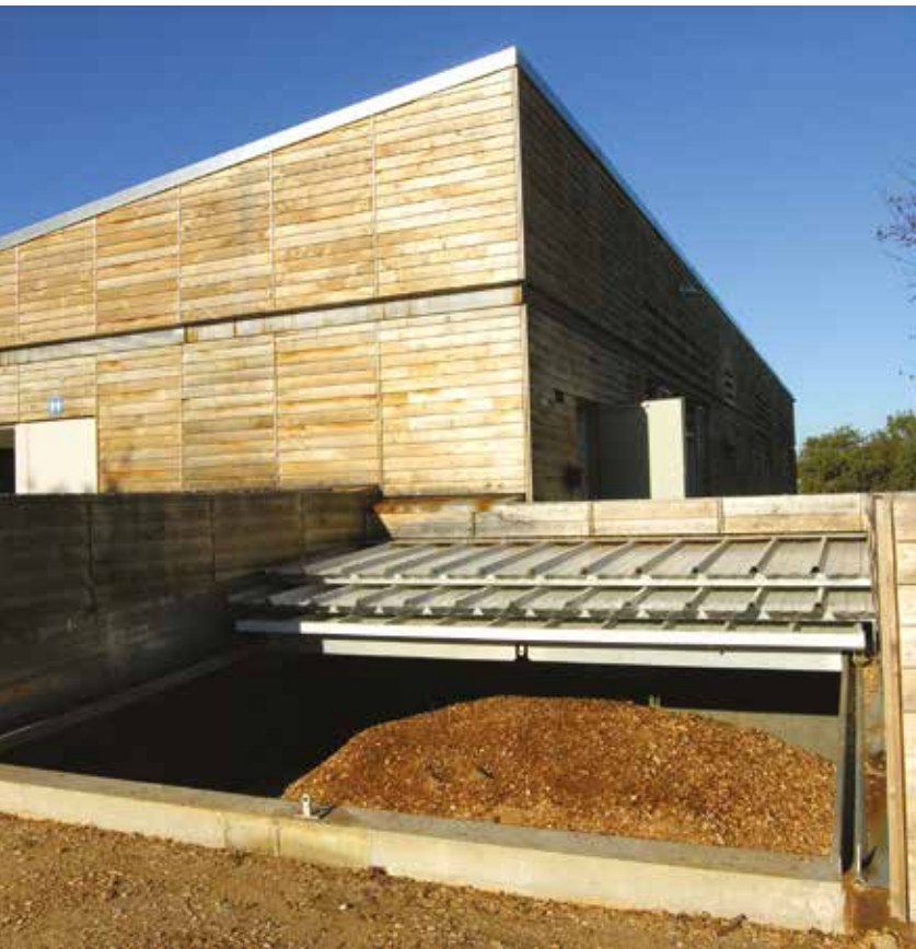
Chaudière bois à la Maison de la Forêt
