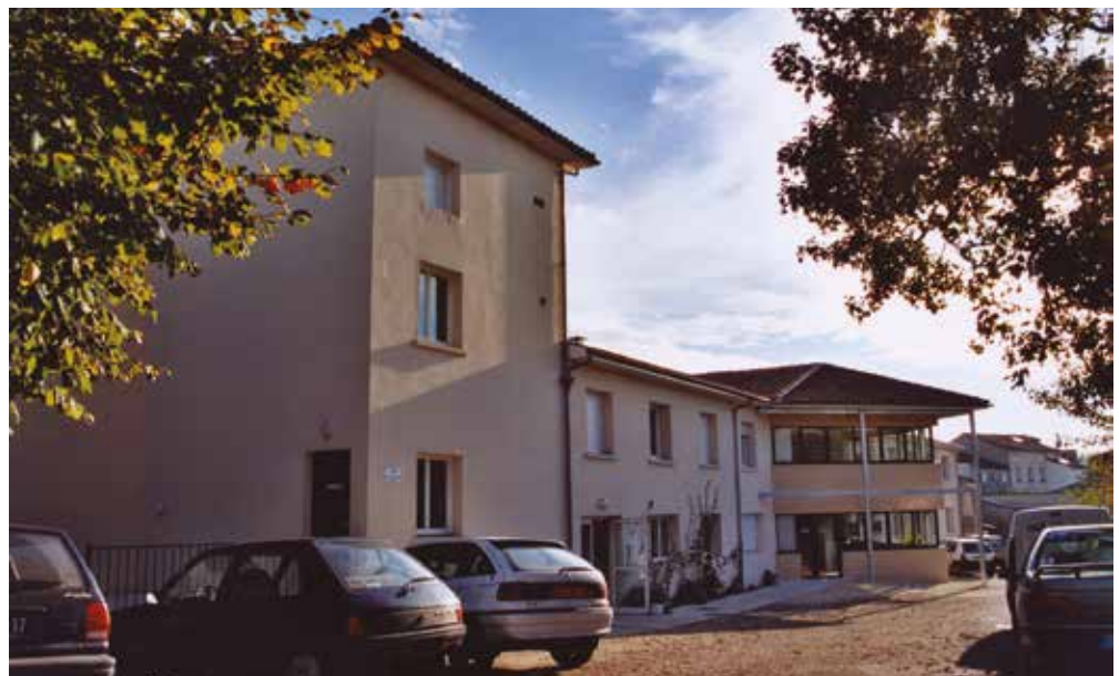
2004 bâtiment CDCHS ensemble
