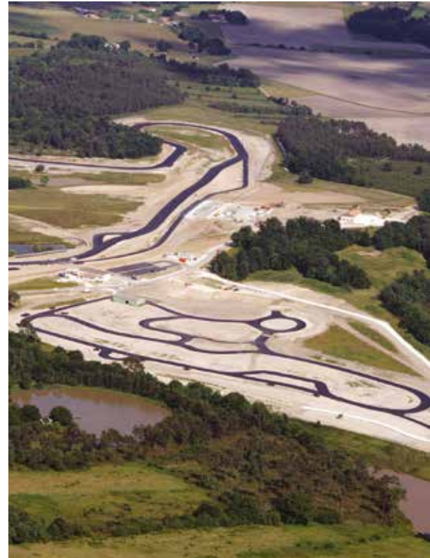
Travaux au circuit Jean-Pierre Beltoise à La Genétouze
