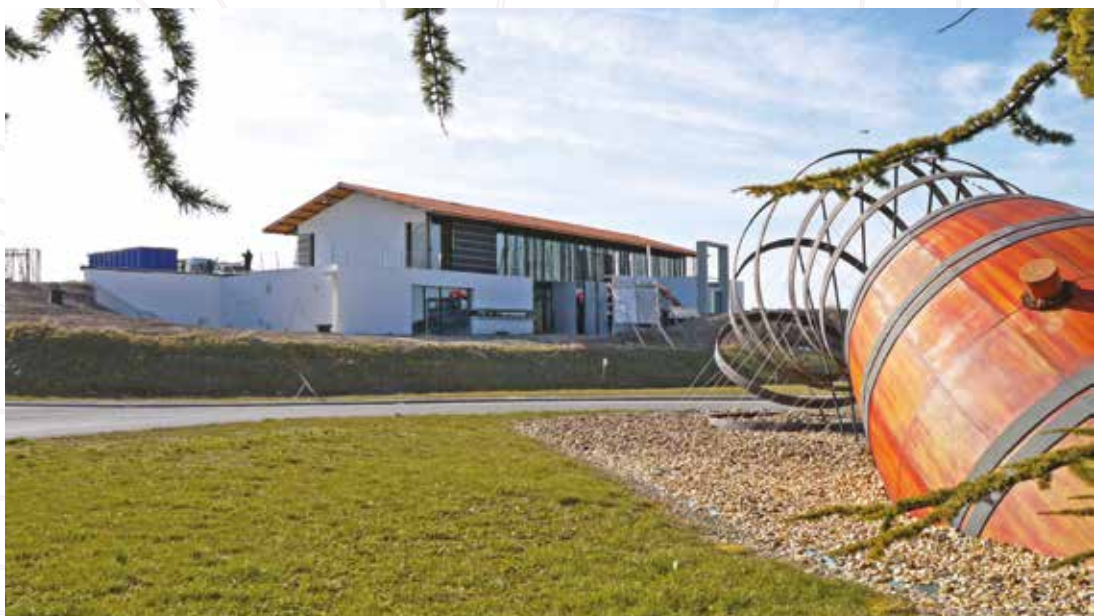
Maison de la Vigne et des Saveurs à Archiac
