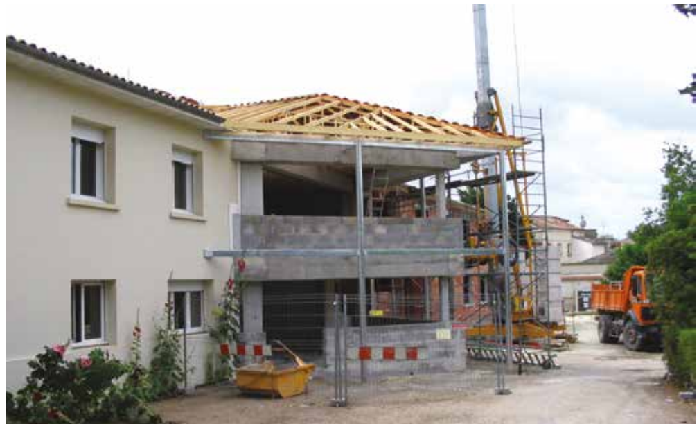
2004, CDCHS, vue d'ensemble du bâtiment
