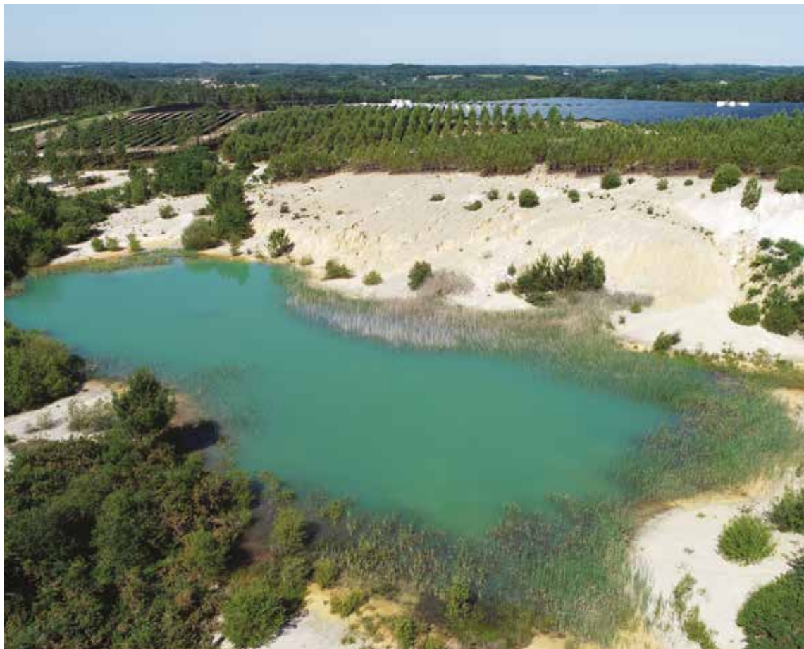
Parc photovoltaïque du Fouilloux
