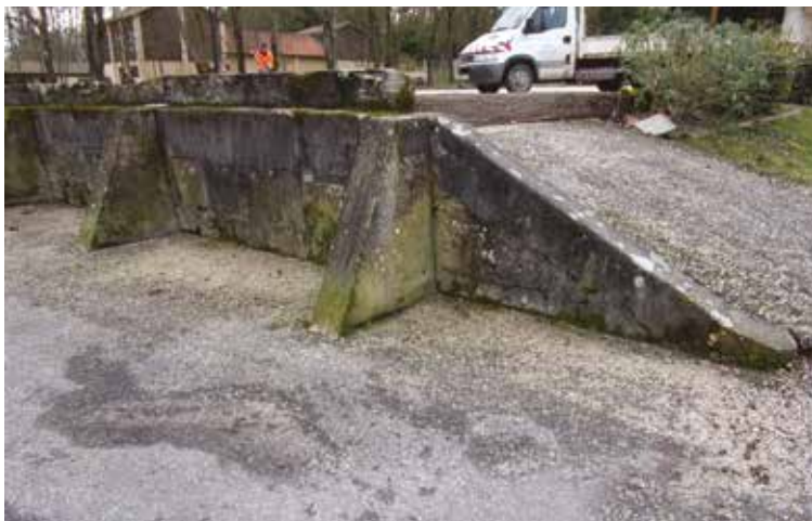
St-Aigulin mur avant rénovation - Photo : © CDCHS, V.Sabadel
