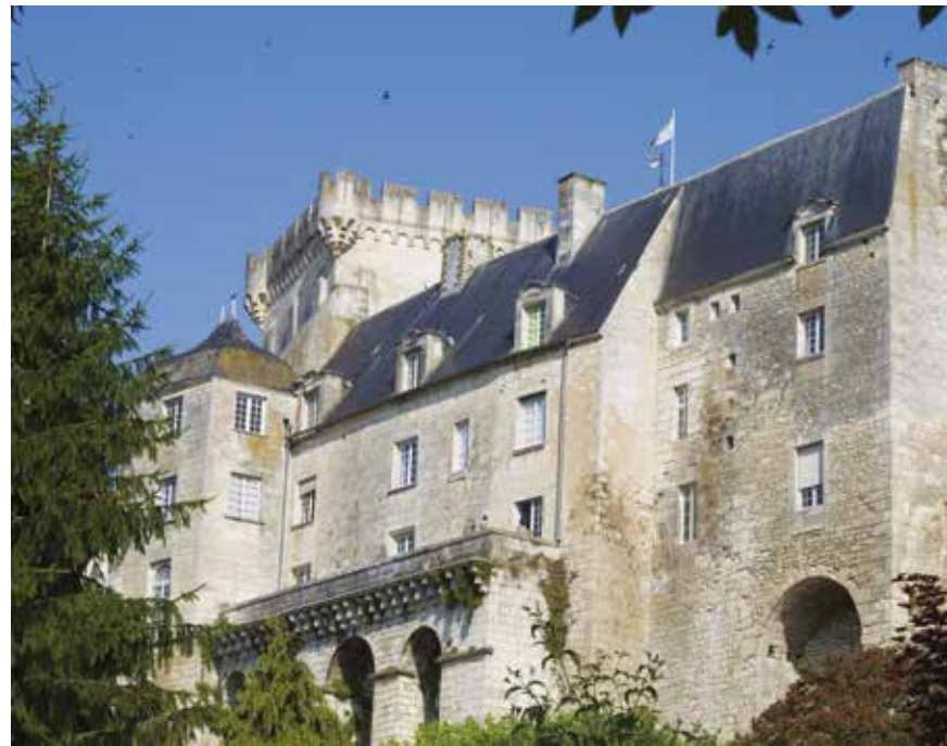
Château de Pons - Photo : © CDCHS, V.Sabadel
