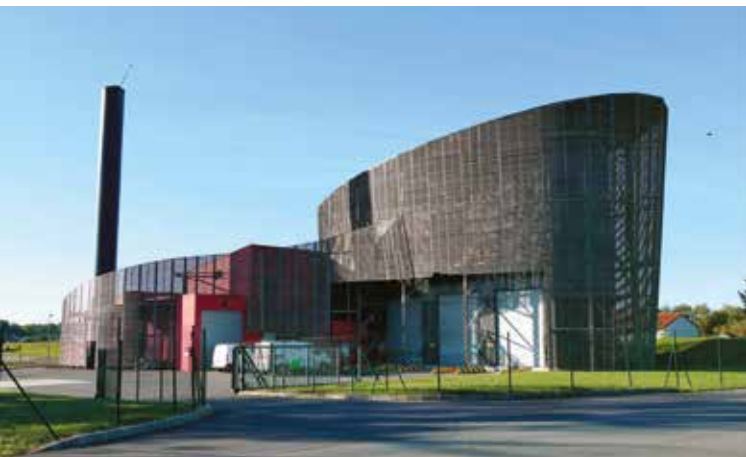
Chaufferie Les Antilles, Jonzac. Photo : © CDCHS / V. Sabadel
