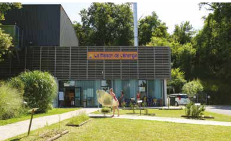
Maison de l'Énergie, Heurtebise, Jonzac. Photo : © CDCHS / V. Sabadel
