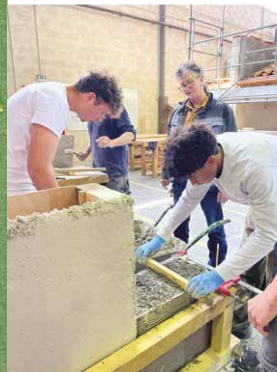
Construction d'une maquette en béton de chanvre - ©Emeline Poulain
