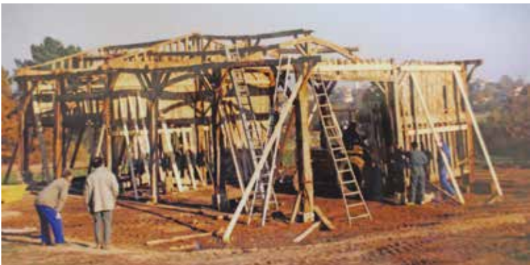
Remontage grange à pans de bois, parc de la Maison de la Forêt, Montlieu-la-Garde
