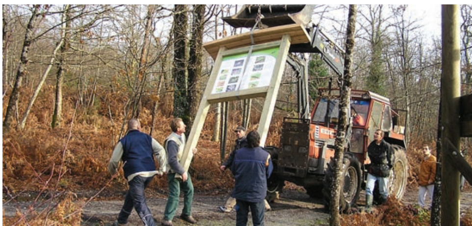
Installation des panneaux informatifs.
