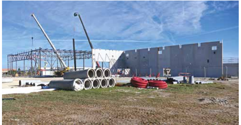
Chantier en cours Daher - ©CDCHS V.Sabadel
