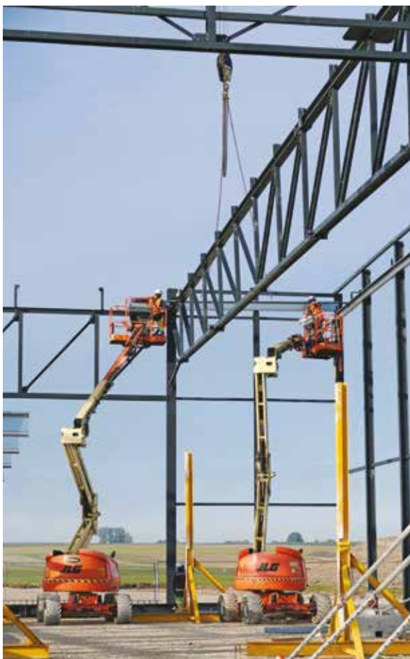
Chantier en cours Daher - ©CDCHS V.Sabadel
