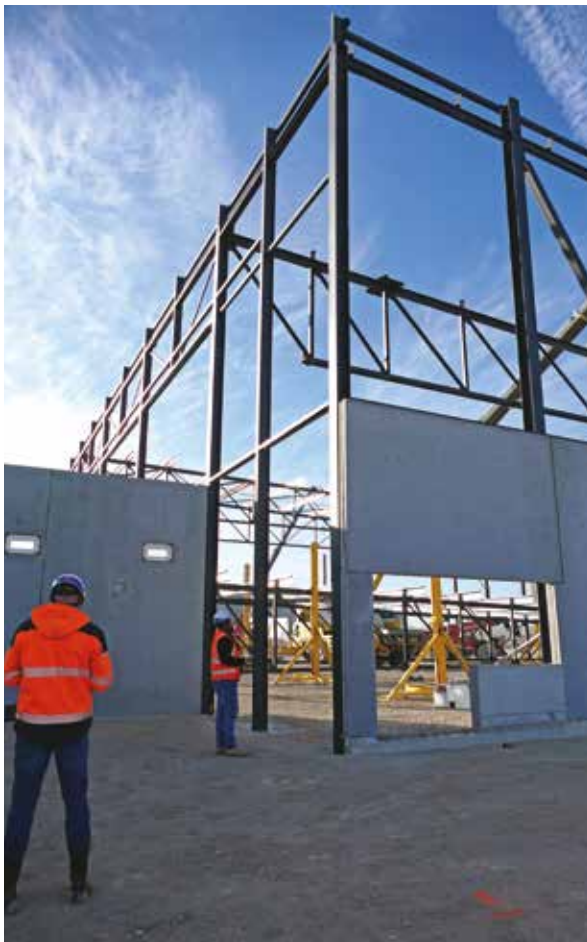
Chantier en cours Daher - ©CDCHS V.Sabadel
