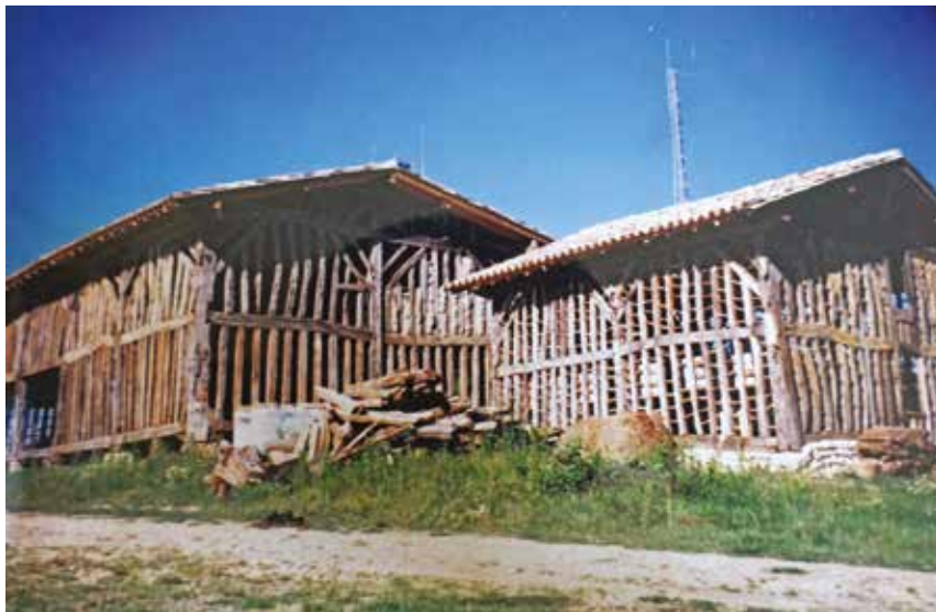
Remontage grange à pans de bois, parc de la Maison de la Forêt, Montlieu-la-Garde
