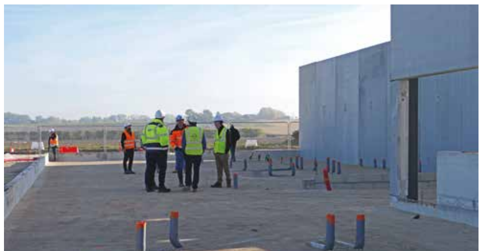
Chantier en cours Daher - ©CDCHS V.Sabadel
