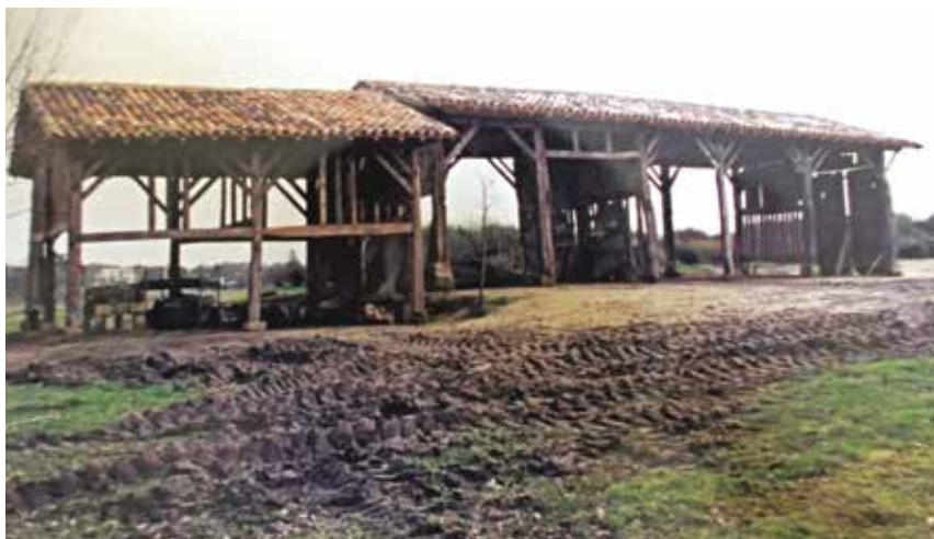
Remontage grange à pans de bois, parc de la Maison de la Forêt, Montlieu-la-Garde
