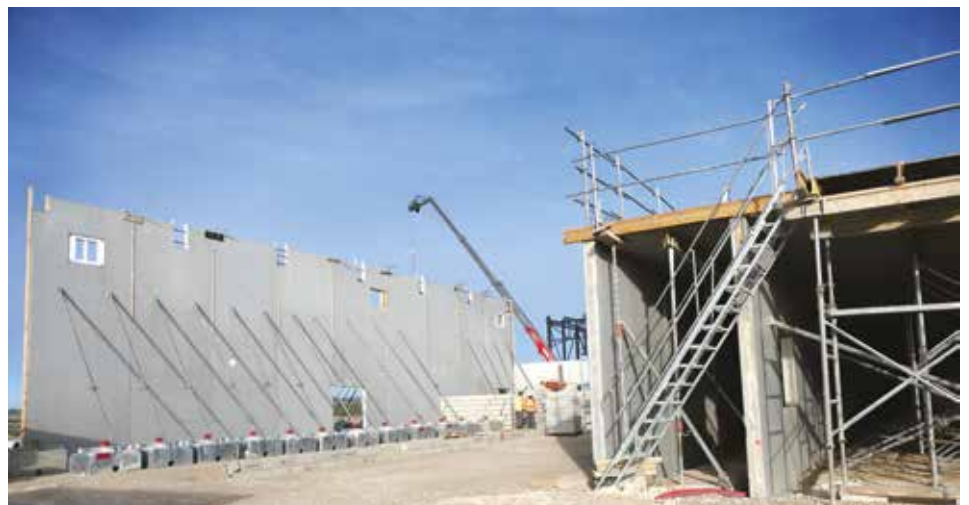
Chantier en cours Daher - ©CDCHS V.Sabadel
